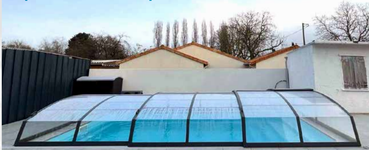
Que la piscine soit protégée par une bâche à barres ou un abri, Frédéric Auger préconise une pompe à chaleur.
